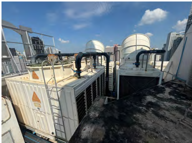
สภาพระบบปรับอากาศ (Cooling Tower)
