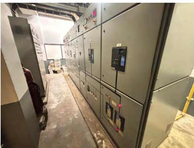
สภาพห้องระบบควบคุมไฟฟ้า (MDB)
