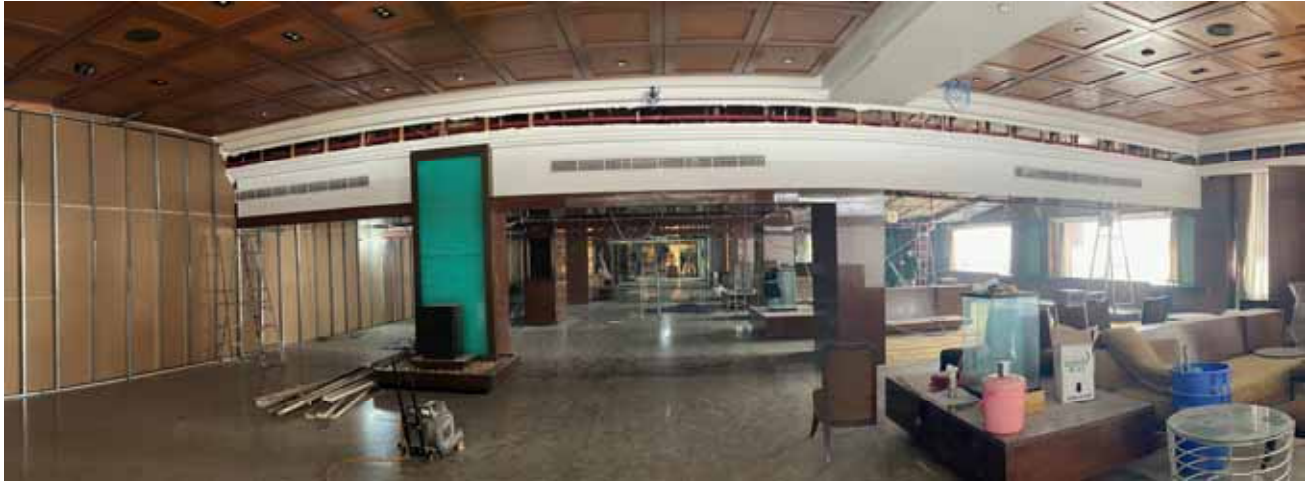
สภาพโถงต้อนรับ (Lobby) ประชาสัมพันธ์ ร้านค้า และห้องอาหาร บริเวณชั้นที่ 1
