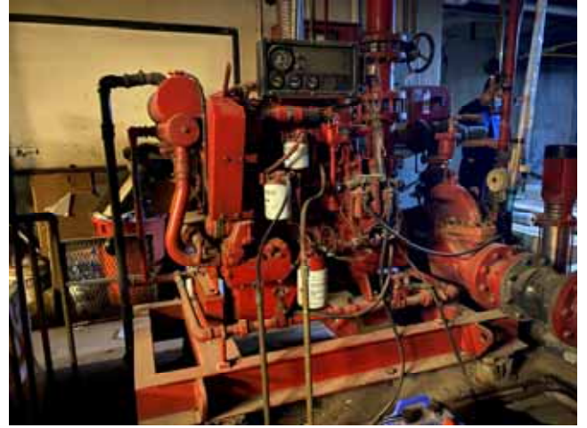
สภาพระบบป้องกันอัคคีภัย เครื่องสูบน้ำดับเพลิง (Fire Pump System)
