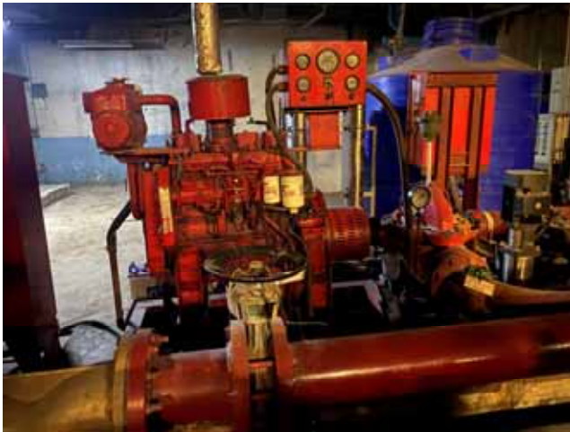
สภาพระบบป้องกันอัคคีภัย เครื่องสูบน้ำดับเพลิง (Fire Pump System)
