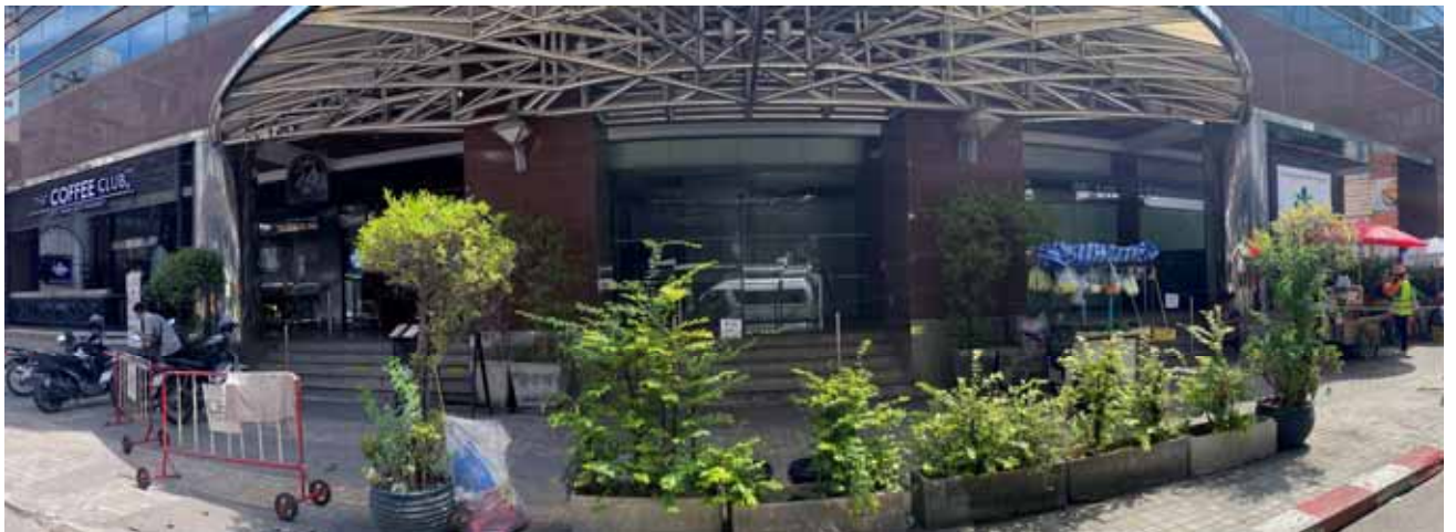
สภาพด้านหน้าทรัพย์สินที่ประเมินมูลค่า อาคารกรุงเทพวิง สูง 27 ชั้นพร้อมชั้นใต้ดิน 1 ชั้น (จุดถ่ายภาพที่ 5)
