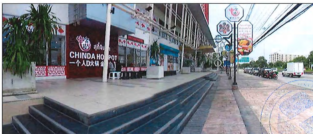
8. สภาพภายนอกอาคาร / บริเวณทางเข้าอาคาร / เถลิง และ พื้นที่ตลาดนัด
