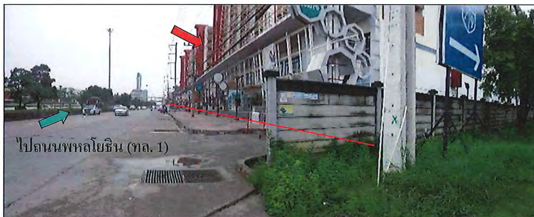
2. สภาพถนนคลองหลวง (ทล.3214)/ บริเวณด้านหน้าที่ตั้งทรัพย์สิน (จุดถ่ายภาพที่ 2 )
