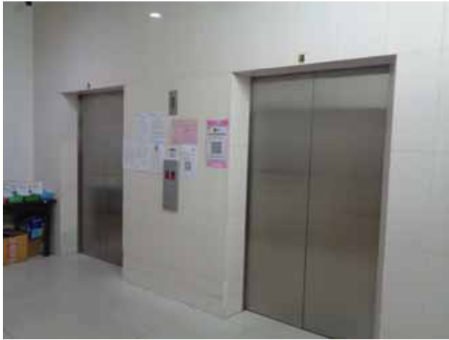
สภาพโถงลิฟต์ส่วนกลาง พื้นที่หอพัก
