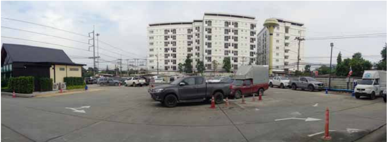
สภาพพื้นที่ลานจอดรถภายนอกอาคาร
