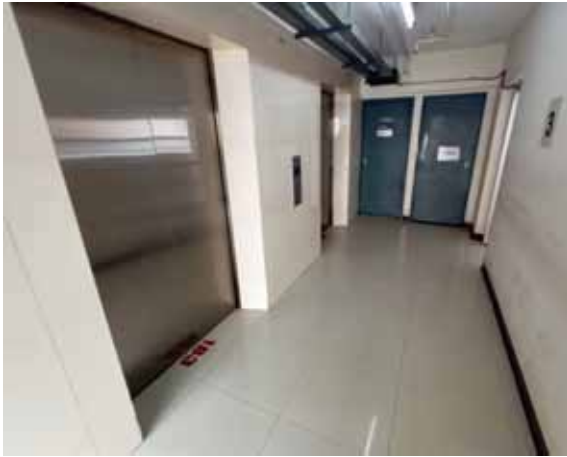
สภาพโถงลิฟต์ส่วนกลาง พื้นที่หอพัก
