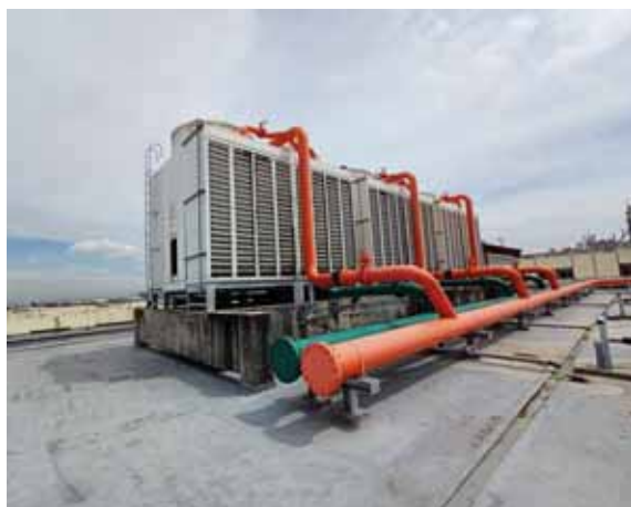
สภาพงานระบบปรับอากาศ พื้นที่พลาซ่า
